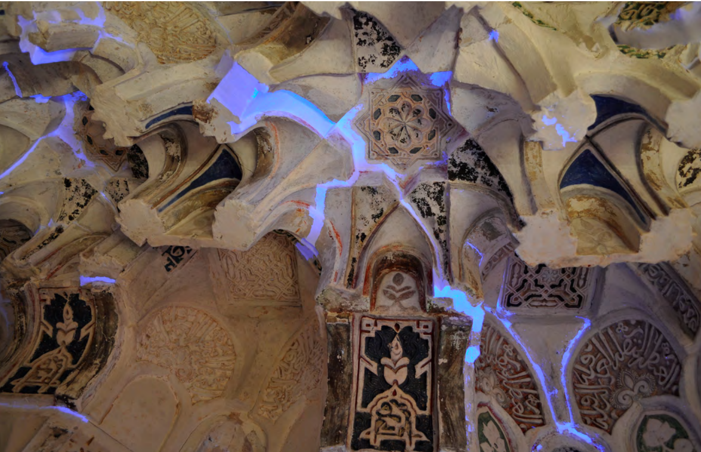
Restauración con la patente de mortero en la Alhambra.
