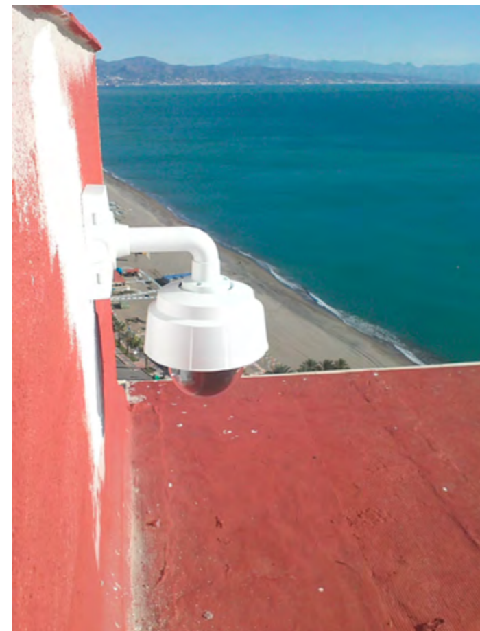
Localización de la cámara SEGVERT.
