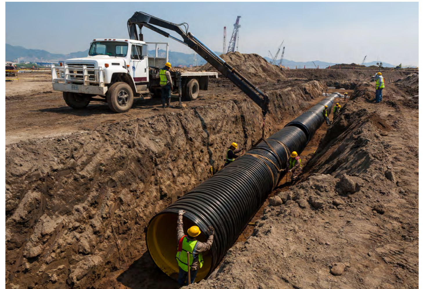
Tubo construido con polietileno reciclado.
